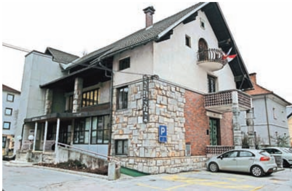
Za zgradbo obstoječe knjižnice bo letos izdelana prostorska presoja za dejavnost medgeneracijskega centra, v letu 2018 pa je načrtovana priprava projektne dokumentacije za obnovo stavbe in prilagoditev novi dejavnosti. / FOTO: GORAZD KAVČIČ
